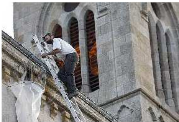
Pose de manchon de capture en sortie de gîte (source : http://www.laroche-bernard.fr )
