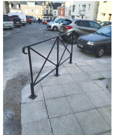
Pose de barrière et réduction des trottoirs aux toilettes de l'église.
