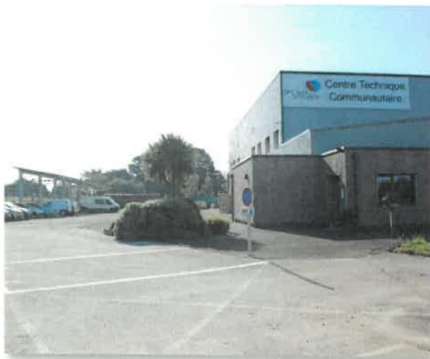
Emménagement des services dans le nouveau Centre Technique Communautaire
