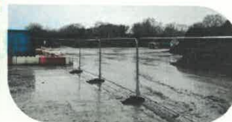
Séparation zone de travaux zone exploitation
