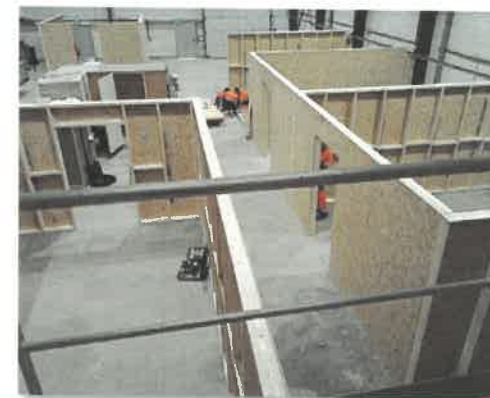
Création des box pour l'aménagement de l'atelier du Centre Technique Communautaire. Cette réalisation a nécessité 305 heures de travail pour 12 agents.
